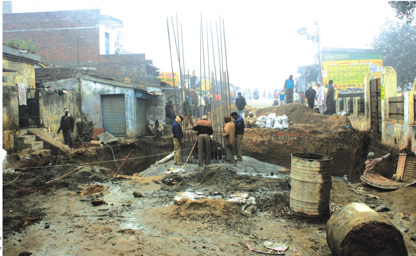
फोटो 6 | पुल का निर्माण
